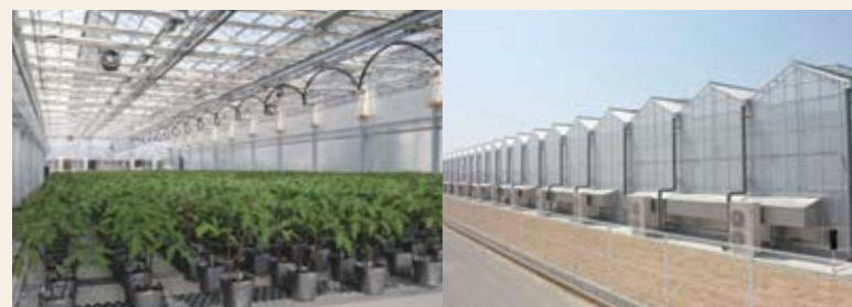
D 高軒高フェンロー型ハウス・補光用ナトリウム灯
