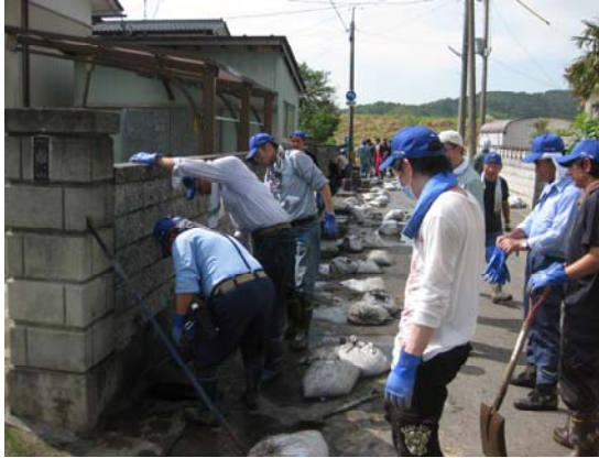
石巻市内の汚泥撤去
