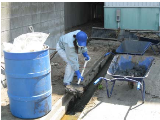
育苗施設の汚泥撤去
