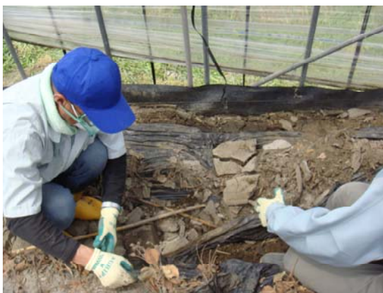
ハウス内の汚泥除去
