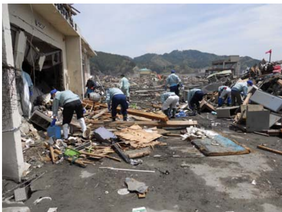
全壊支店から重要書類を回収
