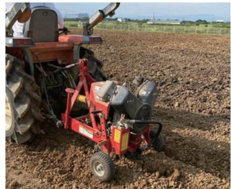
写真1. エアインジェクターによる暗渠施工
